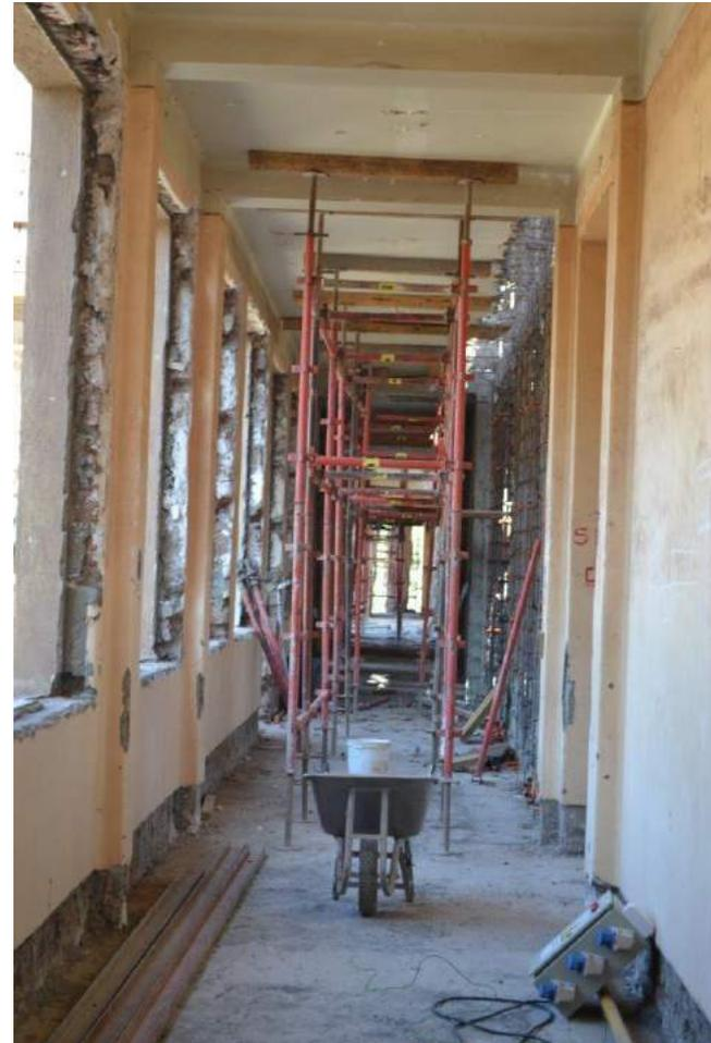
*Estructuras reforzadas con alza prima y pilares estructurales.*
